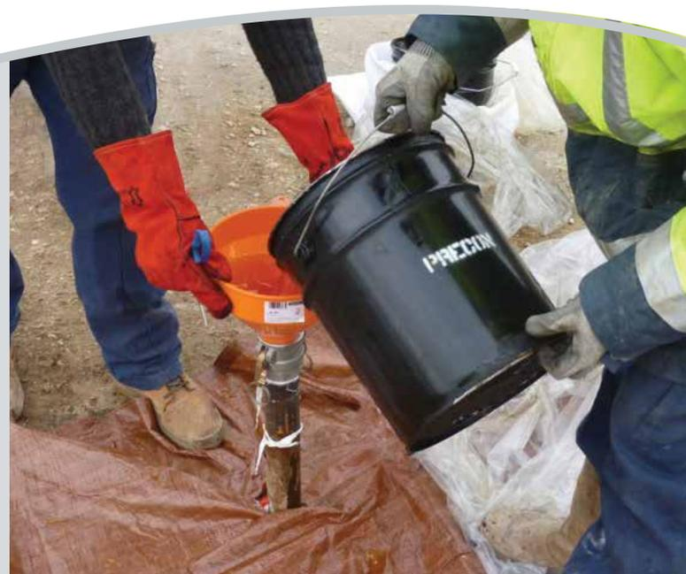
*Trenton Pre-Con® atténue la corrosion qui pourrait être générée par l'eau résiduelle dans la gaine.*
